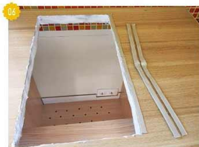
06 Наклеиваем уплотнитель по периметру проёма.
