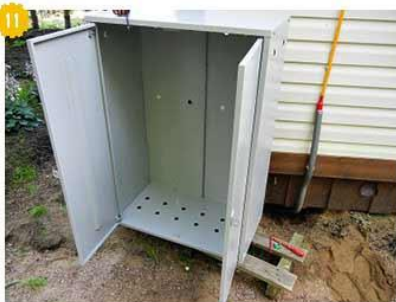
11 Готовый шкаф для баллонов. В днище видны вентиляционные отверстия.
