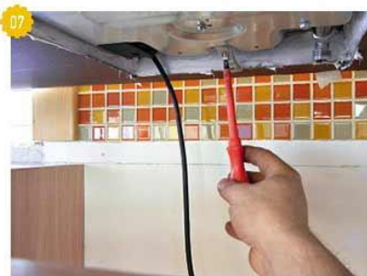
07 Закрепляем варочную панель в столешнице.
