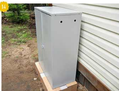
14 Шкаф для газовых баллонов установлен на фундамент.
