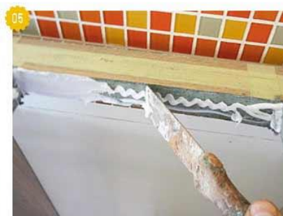
05 Наносим силиконовый герметик на кромки проёма в столешнице.
