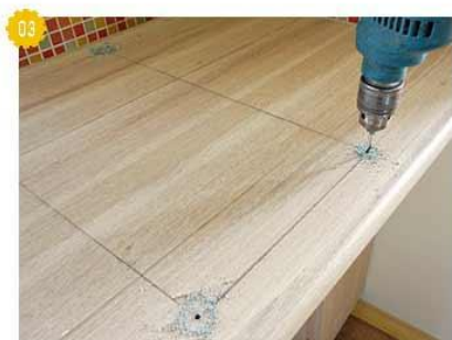
03 Сверлим отверстия по углам проёма в столешнице...
