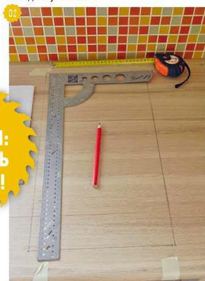
Разметка проёма для установки газовой варочной панели.
