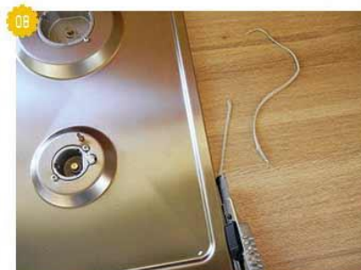
08 Излишки уплотнительной ленты вокруг варочной панели обрезаем.
