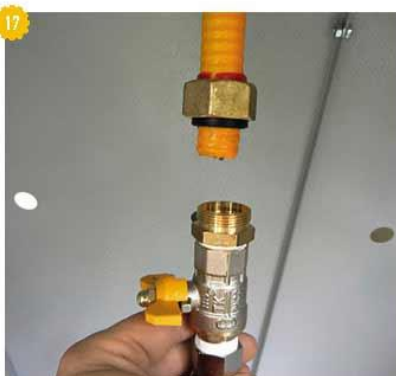
17 Подключение отсекающего вентиля в газовом шкафу.
