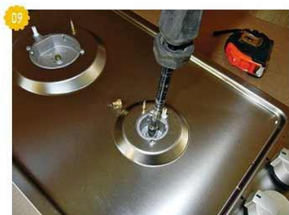
09 Замена форсунок газовых горелок.
