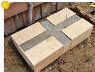
13 Фундамент для баллонов оклеили керамогранитом с широкими зазорами для вентиляции и вывели проводник заземления.
