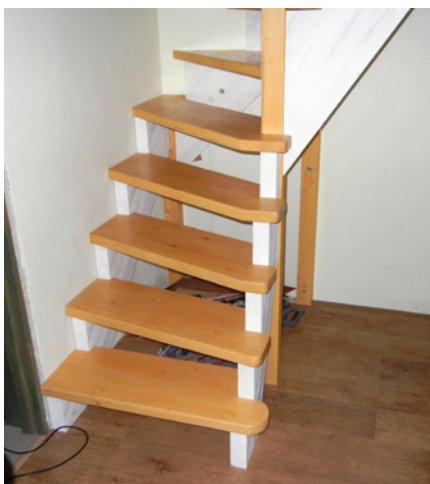
Полностью готовые ступени установили на косоуры.
