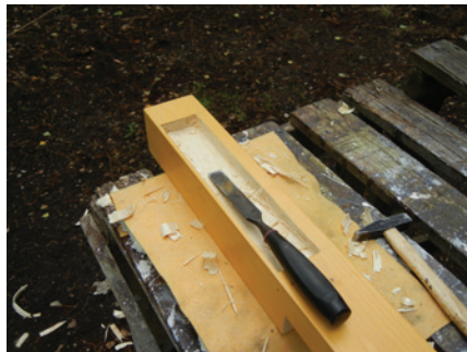
При выборке пазов в заготовках для столбов использовали стамеску и молоток.
