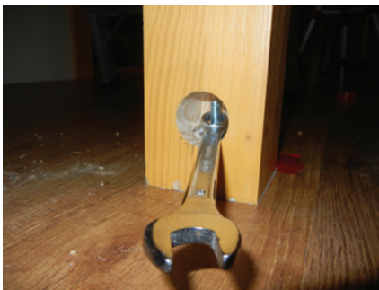
Опорный столб прикрепили к полу с помощью резьбовой сантехнической шпильки, предварительно просверлив под неё отверстия в столбе.
