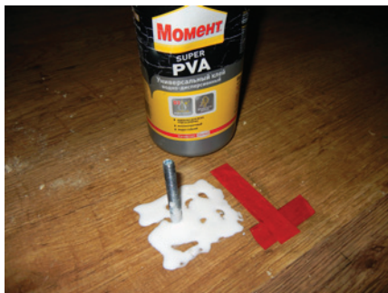
В нужном месте по разметке просверлили в полу отверстие и установили резьбовую сантехническую шпильку для крепления опорного столба лестницы.
