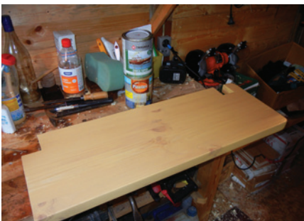
На все поверхности каждой ступени сначала нанесли колерованный антисептик, а потом — яхтный лак.
