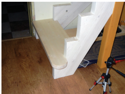
Чтобы избежать травм ног об острые углы ступеней, их скруглили. Особенно важно было это сделать на первой ступени.
