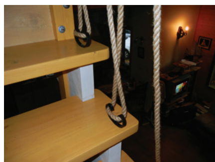
Закончив монтажные работы, натянули джутовый канат диаметром 12 мм на кованые элементы, предварительно окрасив их чёрной краской.
