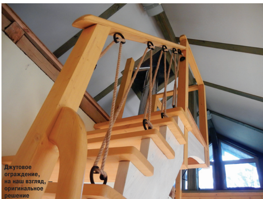
Закончив монтажные работы, натянули джутовый канат диаметром 12 мм на кованые элементы, предварительно окрасив их чёрной краской.
