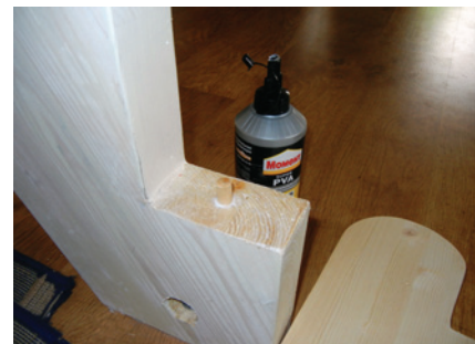
Для надёжного соединения ступеней с косоурами использовали берёзовые шканты и водостойкий клей ПВА.
