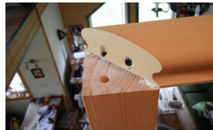
При установке поручней соединяли их элементы на ус над торцами опорных столбов.
