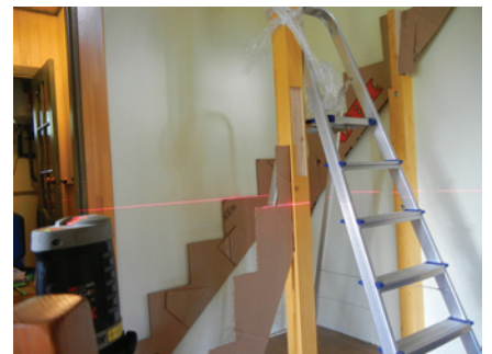
Выставив шаблоны, проверили их взаимное положение лазерным уровнем.
