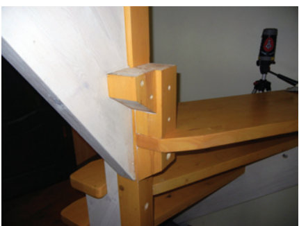
К столбам дополнительно крепили саморезами опорные бруски для забежных ступеней.
