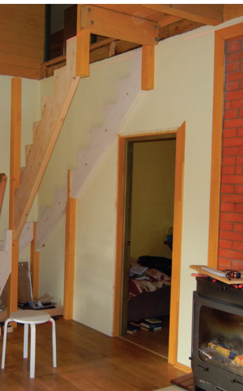
Перед окраской и монтажом горизонтальность каждой ступени проверяли лазерным уровнем.
