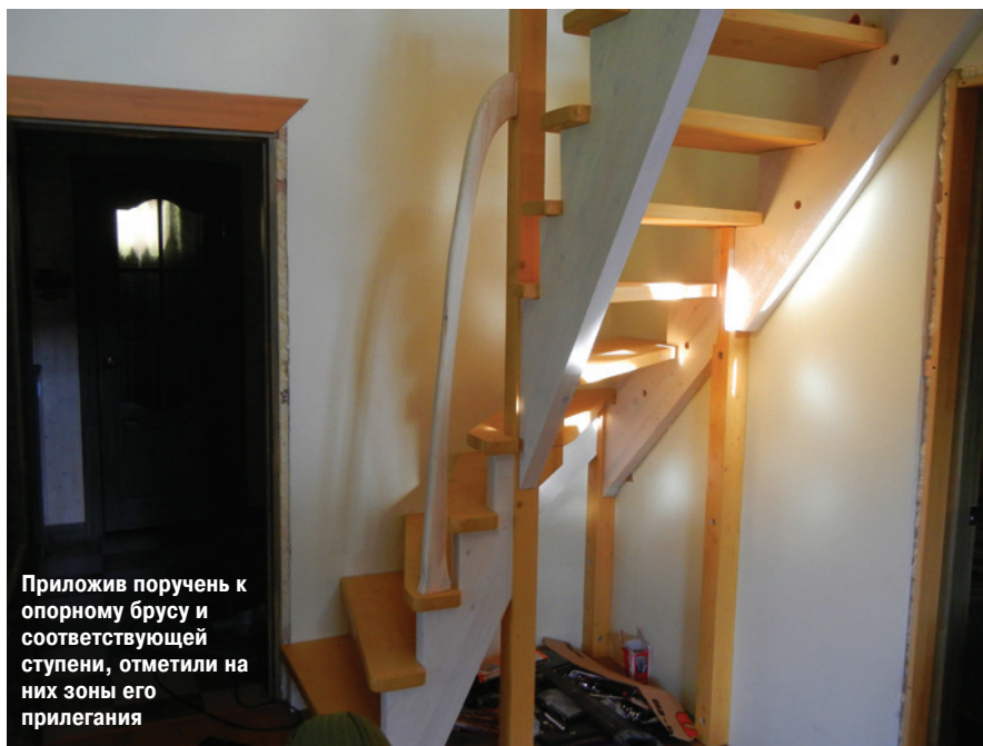
Полностью готовые ступени установили на косоуры.
