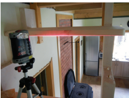
Перед окраской и монтажом горизонтальность каждой ступени проверяли лазерным уровнем.
