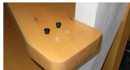
Для установки поручня в ступени и опорном столбе просверлили по разметке отверстия под шканты.
