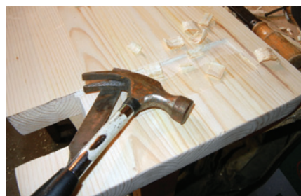
Некоторые ступени всё-таки приходилось подгонять по месту. Для этого с нижней стороны ступени делали стамеской выборку необходимой глубины под опорную площадку косоура.
