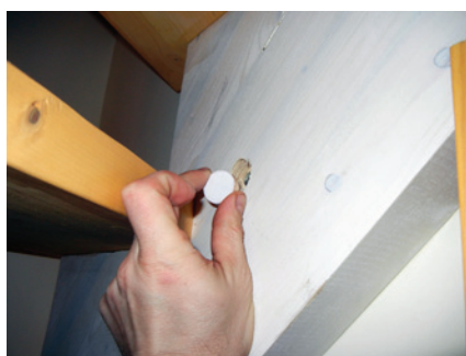
Технологические крепёжные отверстия заглушили окрашенными деревянными пробками.
