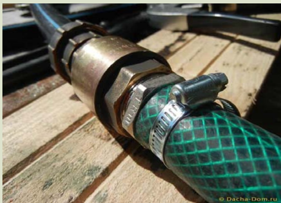
Фотографии №2 и №3. Подключение погружного насоса к трубопроводу через гибкий шланг.
