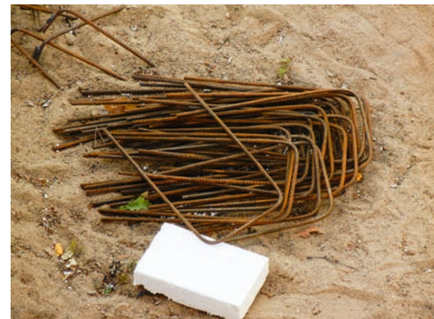
↑ Анкерка углов фундамента. П-образные элементы (хомуты) для анкерки углов ленточных фундаментов или ростверков и торцевых граней фундаментов-плит.
