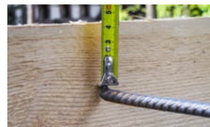
↑ Защитный слой бетона. В части фундамента, не контактирующей с грунтом, толщина защитного слоя бетона будет 4,5 см.
