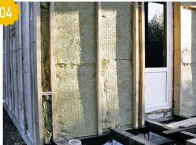
Установка плит утеплителя.
