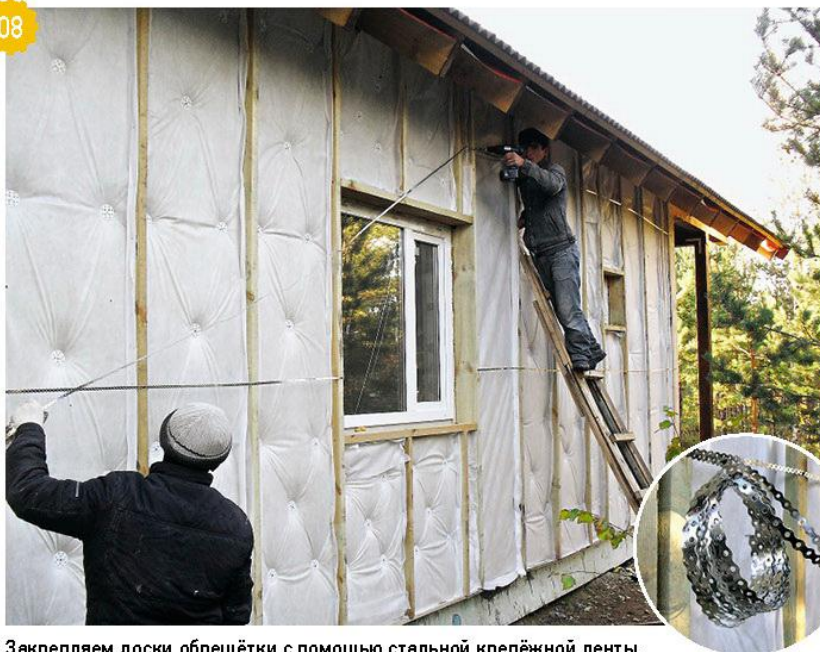
Закрепляем доски обрешётки с помощью стальной крепёжной ленты.
