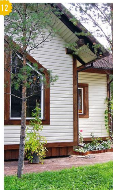
...но использование крашеной доски вместо доборных элементов придало дому дополнительную привлекательность.
