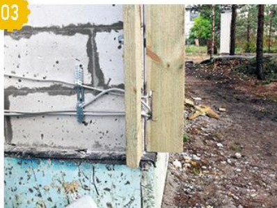
Прокладка кабелей электропроводки по наружным стенам под утеплителем.
