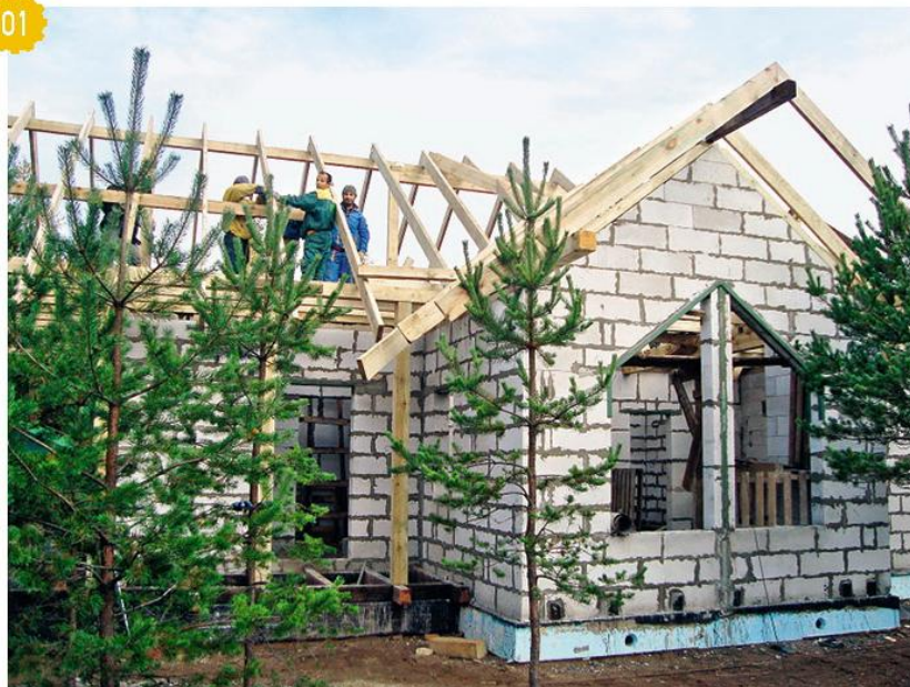
Для строительства одноэтажного дома мы решили использовать газобетонные блоки толщиной 25 см.
