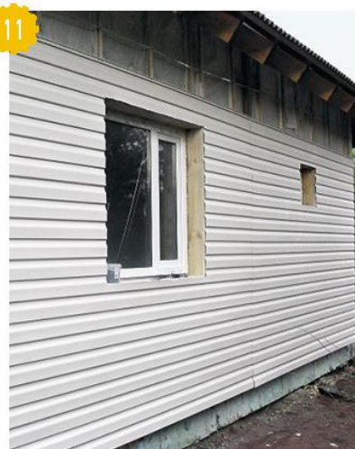
Отделанная сайдингом стена без доборных элементов первоначально выглядела немного странно...
