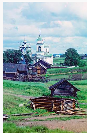
Строительство бани на окраине села Палтога Вологодской губернии. 1909 г. Фрагмент фотографии С.М. Прокудина-Горского из коллекции Библиотеки Конгресса США.
