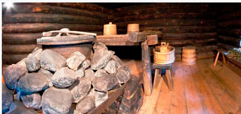
Каменка – комелёк (сложенная из камней насухо) курной бани с котлом для нагрева воды из деревни Мижостров, Карелия в музее деревянного зодчества «Малые Карелы». 2014 г. Фотография с сайта www.korely.ru
