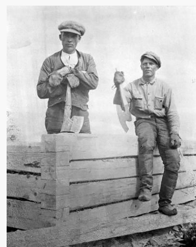
Финские плотники - строители сауны в Куопио. Культурно - исторический музей Куопио.
