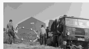
Сборка мобильной бани на базе дегазационно-дезинфекционной установки ДДА-66 в разрушенном землетрясением селении Сары Камыш в Киргизии 5 июня 1970 года.
