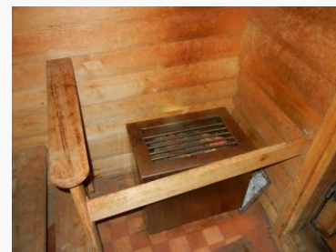
Электрокаменка корабельной бани ПЛА проекта 949 «Гранит». 2015 г. Фотография автора.
