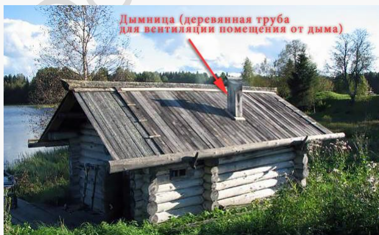
Новодельная осиновая курная вентиляруемая баня с дымовницей в деревне Гужово Каргопольского района Архангельской области, построенная по обмерным чертежам бани XIX века из музея деревянного зодчества «Малые Карелы». 1990 год. Фотография Дмитрия Соколова с сайта www.novoestaroie.ru
