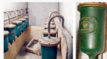
Система фильтров для воды в Зимнем дворце.
