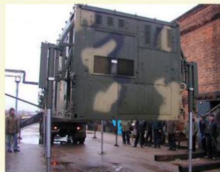
СМ-695. Теплопункт. Установка на площадку с помощью ГПРУ.
