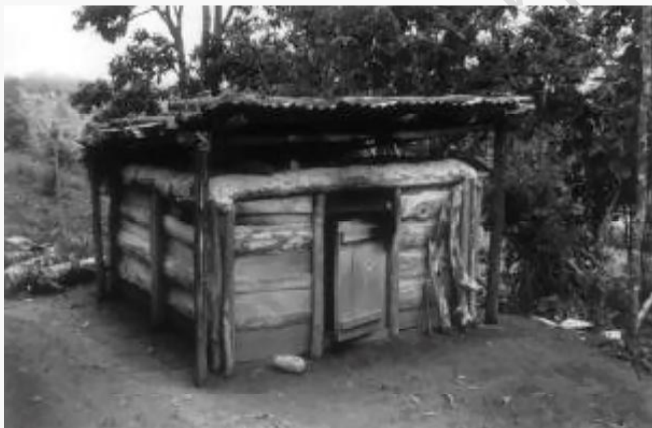
Kevin P. Groark. Индейская баня из досок с плоским глинобитным потолком и плоской кровлей из мексиканской провинции Осчук. 1997 г. [Groark K.P., 1997].
