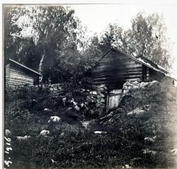
Сауна-полуземлянка в склоне холма (сауна сапожника) в общине Кухмойнен, Финляндия. 1916 г. Фотография: Gösta Grotenfelt
