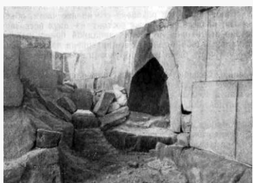
Топочная камера гипокауста бани патриаршего дворца в Звартноце, Армения. 1960 г. Фотография: О.Х. Халпахчян.
