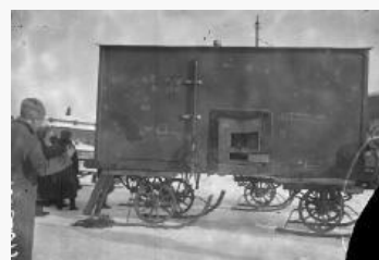
Русская окопная передвижная баня на конной тяге. Вид бани со стороны печи. (Печь топилась снаружи, как и современных автомобильных бань). 1885 г.
