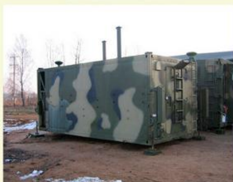
СМ-695. Теплопункт. Установлен на площадку.
